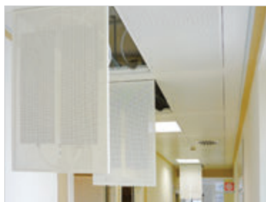
Inspecionabilidade do teto radiante metálico
