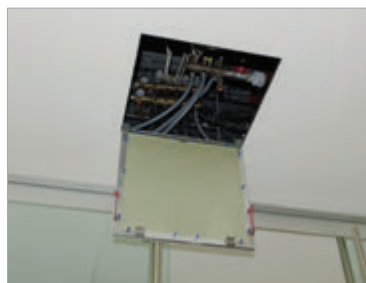
Inspecionabilidade do teto radiante em cartão gesso
